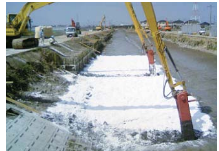
高有機質土、超軟弱土用石灰系アースライムB-K使用による河川改修工事。
