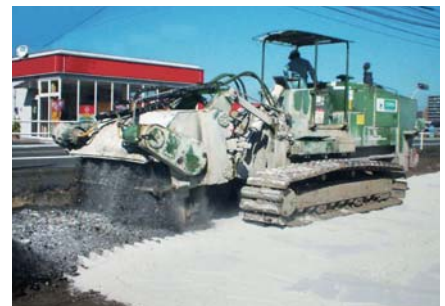
市街地でのテフロン®処理防塵石灰系スーパーアースライム使用による道路改良工事。
