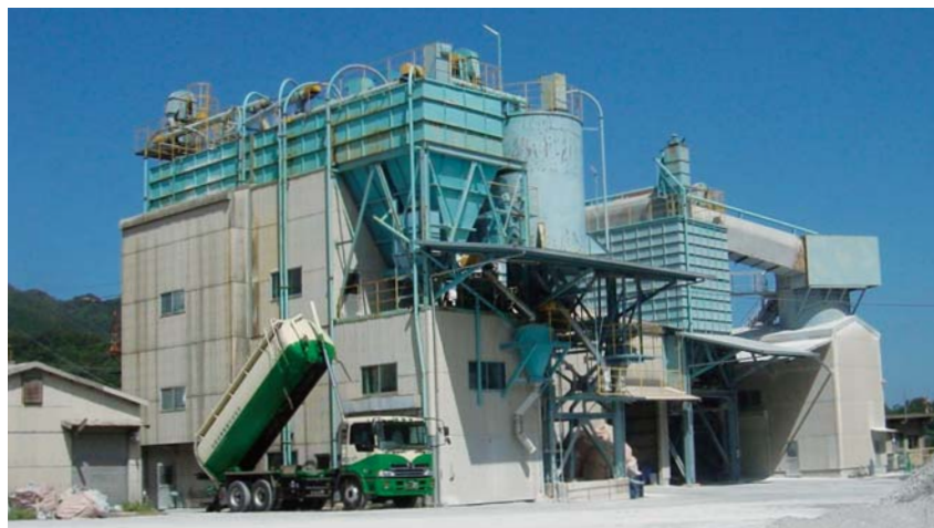
石灰系3種混合・テフロン®処理防塵固化材製造設備
