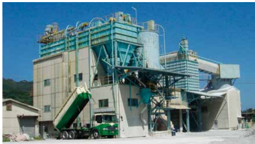
石灰系3種混合・PTFE処理防塵固化材製造設備
