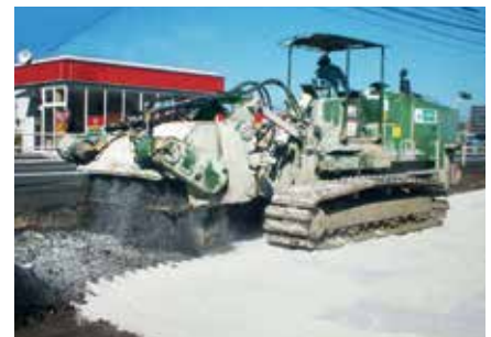
市街地でのPTFE処理防塵石灰系スーパーアースライム使用による道路改良工事。
