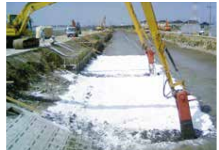
高有機質土、超軟弱土用石灰系アースライムB-K使用による河川改修工事。
